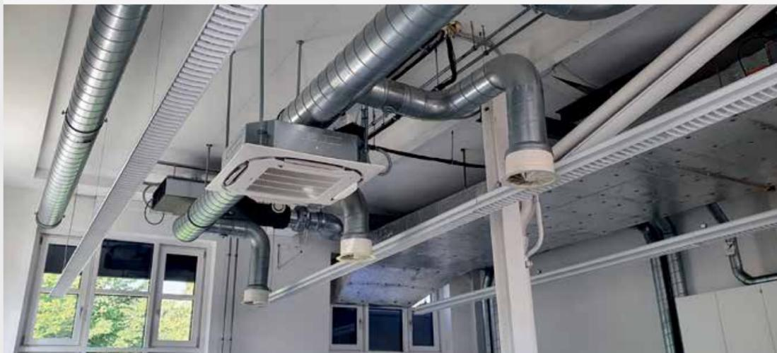
Das Deckengerät sorgt mit verschiedenen Modis für die Verteilung der kühlen Luft.
