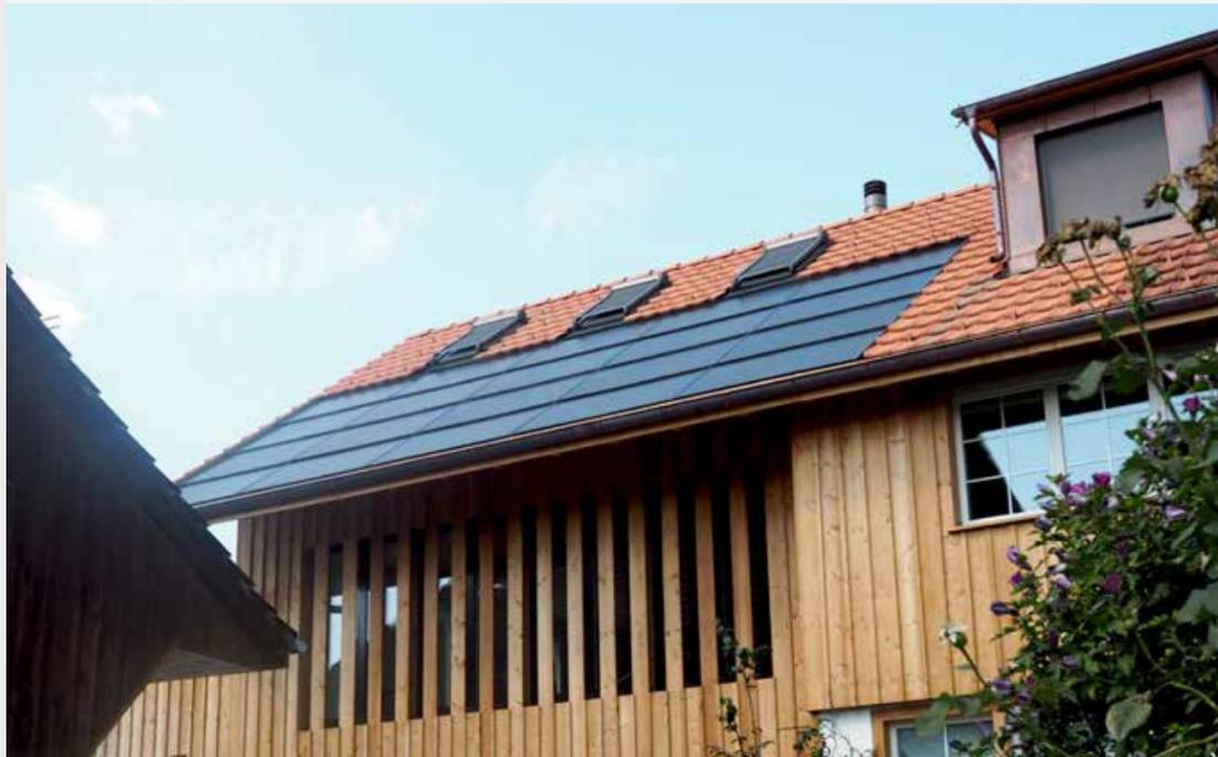
Indach-Photovoltaik-Anlage bestehend aus 20 Modulen, Gesamtfläche rund 30m<sup>2</sup>.
