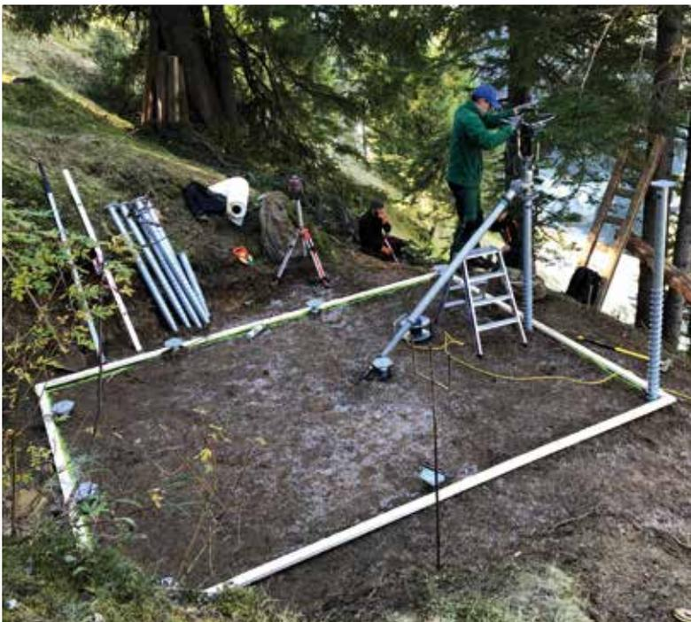
Krinner Schraubfundamente verdrängen beim Eindrehen das Erdreich. So entsteht ein stabiles Fundament für Bauten aller Art. Verschiedene erlauben eine sehr grosse Anwendungsvielfalt.
